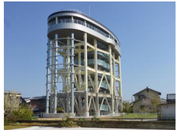
(高知県黒潮町、写真/時事) 高さ22m、収容人数230人と日本最大級の津波避難タワー
